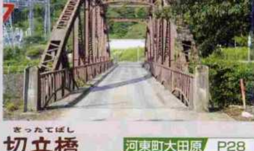
河東町大田原 P28 切立橋
